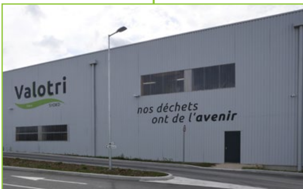
Premiers essais de Valotri, le nouveau centre de tri de Catus
