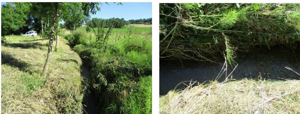
Vues générales de la station
