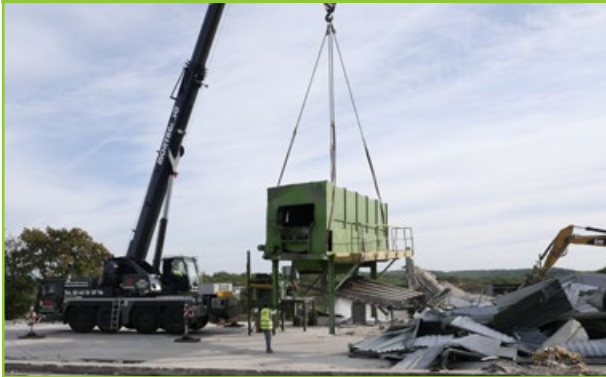
Déconstruction écoresponsable de l'ancien centre de tri de Catus
