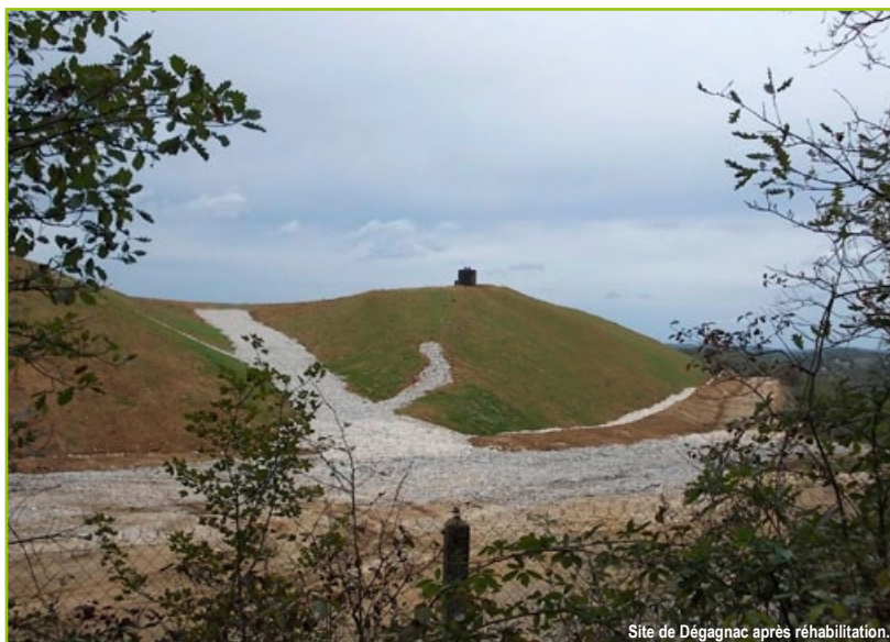
Site de Dégagnac après réhabilitation.
