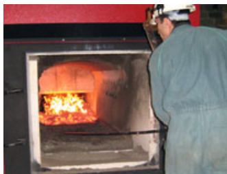
Maintenance de la chaufferie
