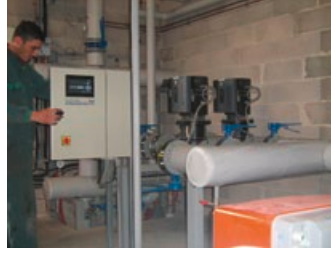
Maintenance de la chaufferie
