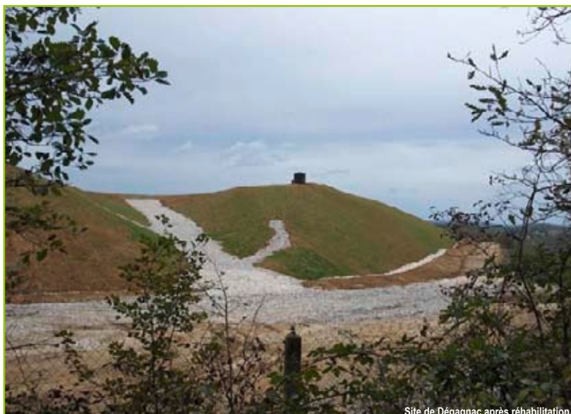
Site de Dégagnac après réhabilitation.
