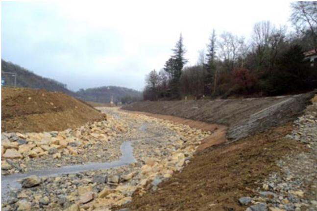
Les travaux importants menés sur le plan d'eau du Lac vert se sont divisés en 2 phases : vidange complète du plan d'eau, puis son curage et sa déconnexion du Vert.
